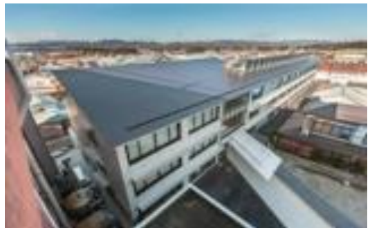
完成した厚寿苑全景（鹿島厚生病院屋上より）
