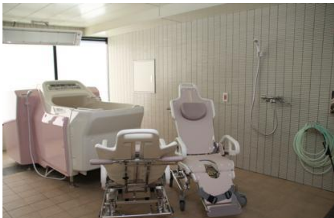
機械浴室、個浴室を配備した入浴施設
