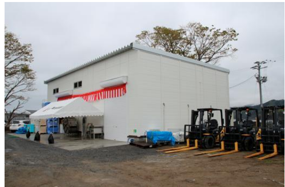
水揚げ、生産の拠点となる製氷、冷凍荷捌き施設
