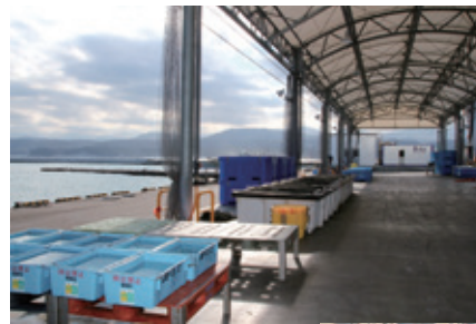
荷捌き施設を整えた野田村漁協魚市場
