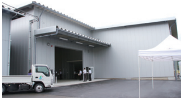
東部共同農業倉庫低温農業倉庫 ●鉄骨平屋建て●建物943㎡、敷地1309.50㎡
