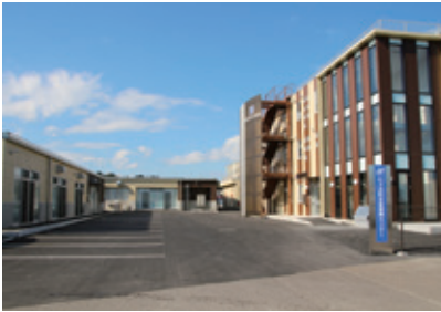
宮城県漁業協同組合 七ヶ浜町水産振興センター建設事業
