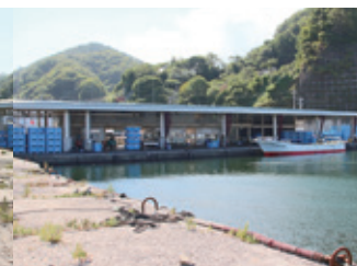
荷捌き施設を修復（太田名部漁港）
