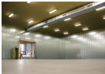
福島県東西しらかわ農業協同組合 地域農業再生基幹施設緊急整備事業
