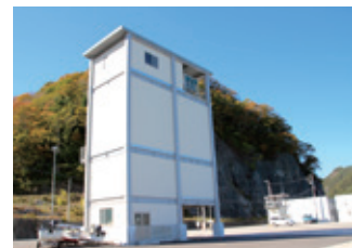
被災した製氷・貯氷ユニットを修繕（写真左）、製氷能力（10t/日）・貯氷能力（15t）として復旧（田野畑村漁業協同組合）
