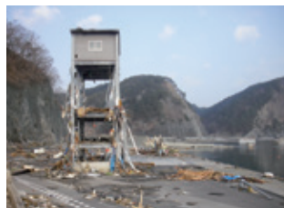
被災した製氷・貯氷ユニットを修繕（写真左）、製氷能力（10t/日）・貯氷能力（15t）として復旧（田野畑村漁業協同組合）
