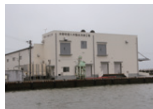
洋野町の製氷・貯氷施設 ●鉄筋コンクリート造り（一部鉄骨造り、一部2階建て）●延床面積：1516.27㎡ ●製氷能力：71.8t /日 ●貯氷能力：317t
