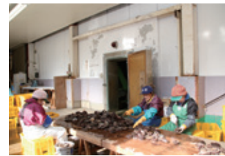
被災した冷蔵施設を修繕し入口を作業場に、奥を倉庫に
