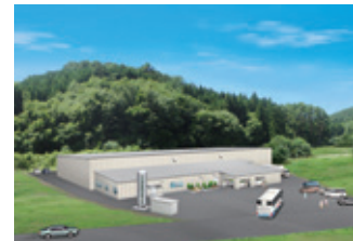
川内村高原農産物栽培工場 ●鉄骨造、完全人工光型（完全閉鎖型）●建築面積：2467.10㎡／敷地面積：5009.10㎡●栽培面積：4324.8㎡（9.01㎡×8段15ライン×4室）●栽培予定作物：リーフレタス類、ハーブ類●目標雇用人数：25人
