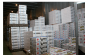
久慈市冷凍水産加工業協同組合 最新凍結設備トンネルフリーザーも完備(写真上)、修繕した冷凍倉庫(写真下)
