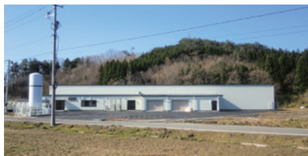
完成した水耕栽培の新工場
