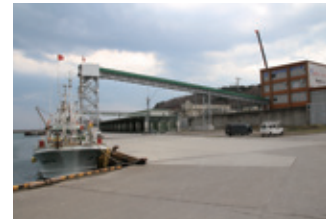
2012年12月に完成した製氷・貯氷施設（久慈市）
