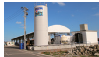
スラリー氷製氷能力 18.5t、ドライ氷製氷能力 5t、貯氷能力 30tとなる新施設（野田村漁業協同組合）
