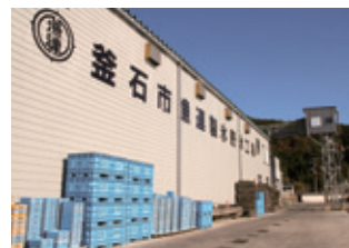
再稼働した製氷・貯氷施設（釜石市新浜町魚市場）
