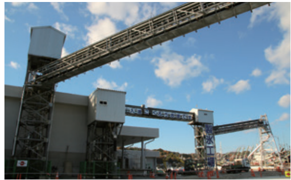
再建された製氷・貯氷施設（製氷能力は100t／日、貯氷能力は1000t）
