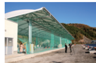
接岸場所を長くし大型漁船も接岸可能にした新浜町魚市場
