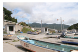
船を浜に引き揚げる、巻揚げ機を綾里漁港、港地区に4機設置
