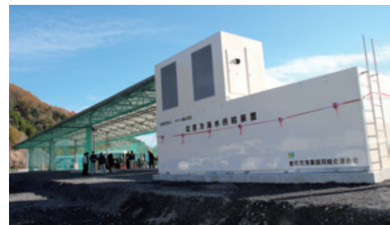
殺菌冷海水装置 30t（新浜町魚市場）
