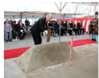
5月8日、新築工事起工式を開催
