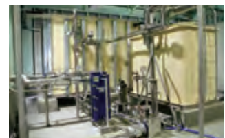
復旧した洋野町営八木市場。汲み上げた海水の濾過・冷却・殺菌し市場内に送る海水冷却装置と断熱貯水タンク（写真下）
