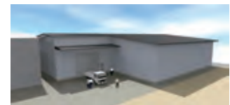
9月竣工の東部地区農業倉庫
