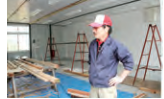
内装工事中の仮設加工団地
