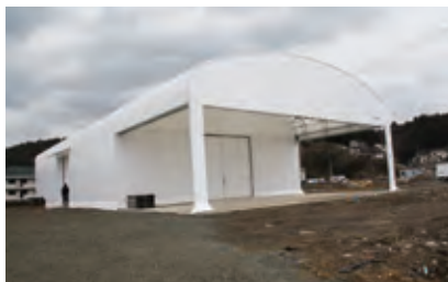
仮設ワカメ作業所
