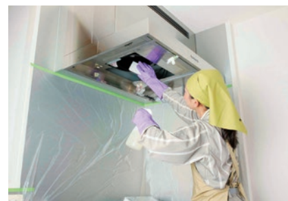
換気扇の清掃
